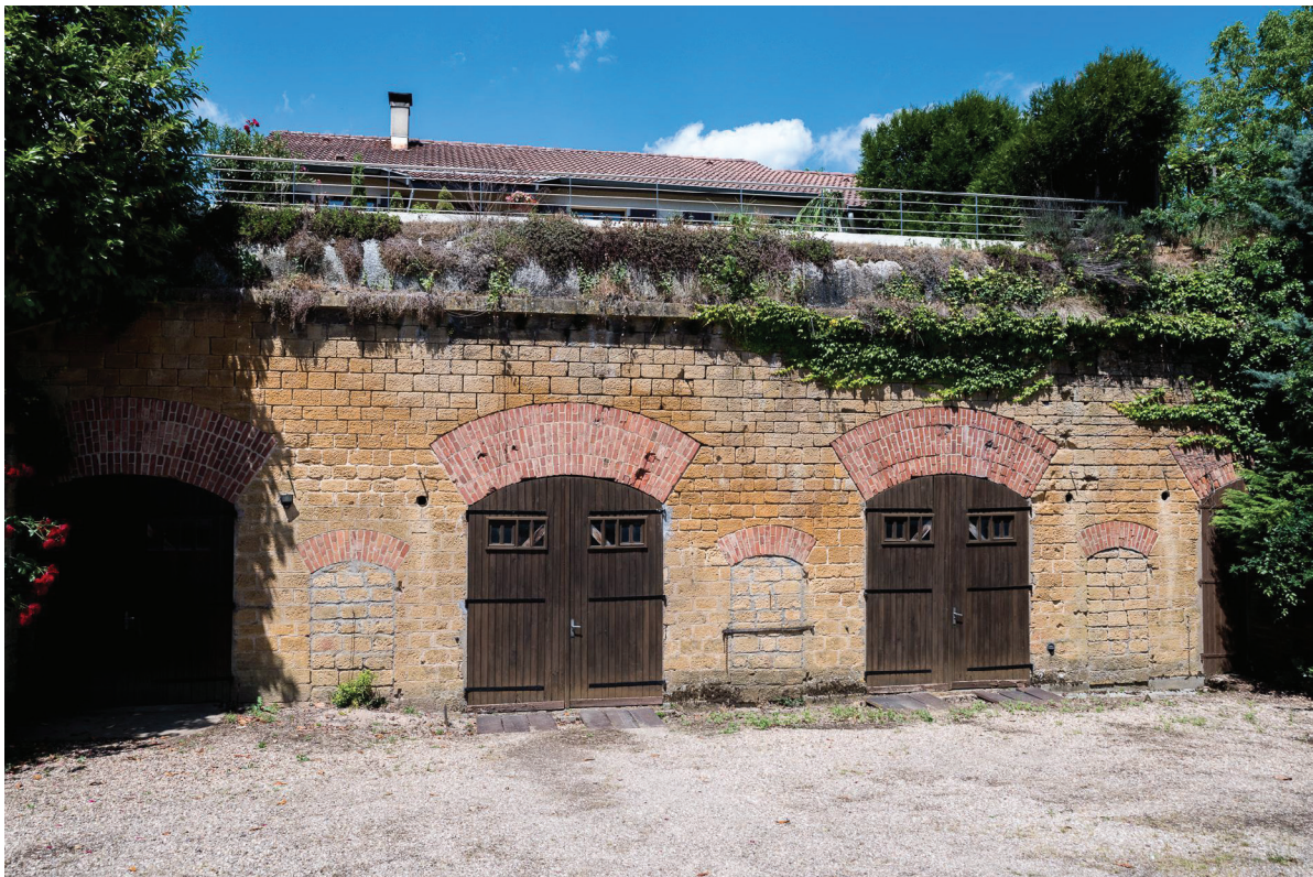
1. L'abri d'infanterie à cinq travées, construit sous l'Annexion en 18988.
