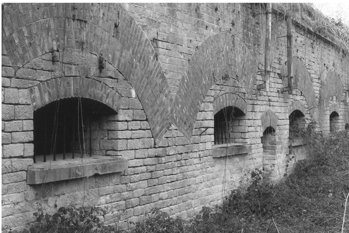
2b. Un abri d'infanterie identique à l'ouvrage militaire de la famille Jénot, dans son état d'origine (photo extraite de notre Bulletin n° 5).
