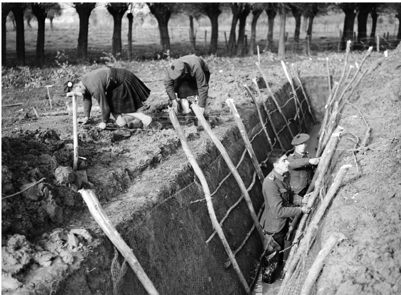
Désœuvrés, les soldats creusent et peaufinent les tranchées.
