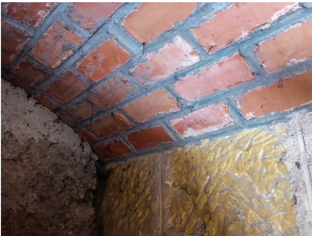
18. La voûte en briques et le mur en pierre de Jaumont où se trouvent les graffitis.
